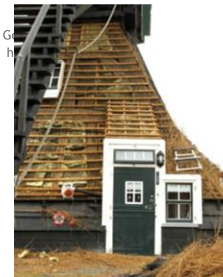
Gedeelte van de ondertoren waarbij het riet is verwijderd
