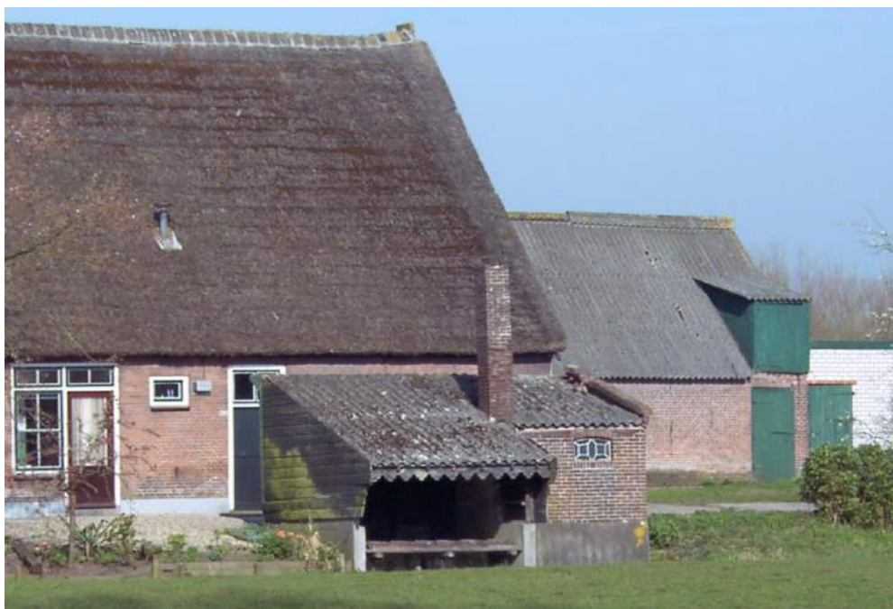
Drie verschillende soorten dakbedekking op een erf: riet op het hoofdgebouw, asbest golfplaten op het speel- en stookhok en zinken golfplaten op de schuur.
